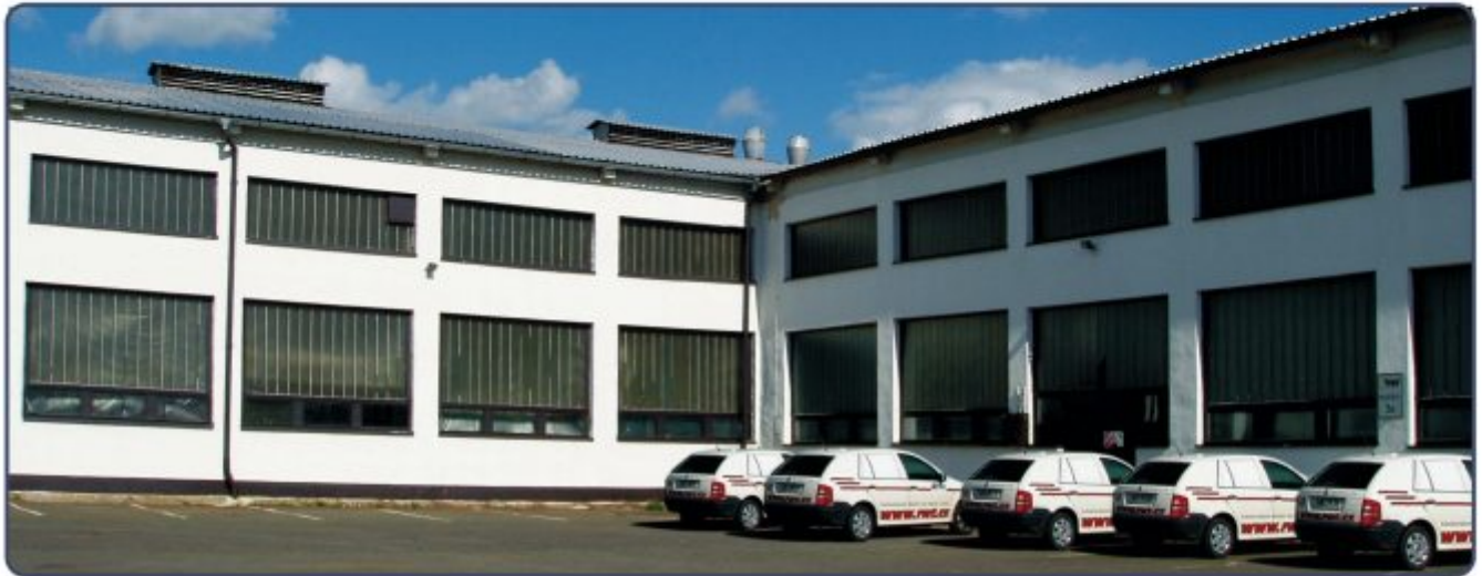
Factory - Das Werk - Výrobní závod - Fabryka - Производство
